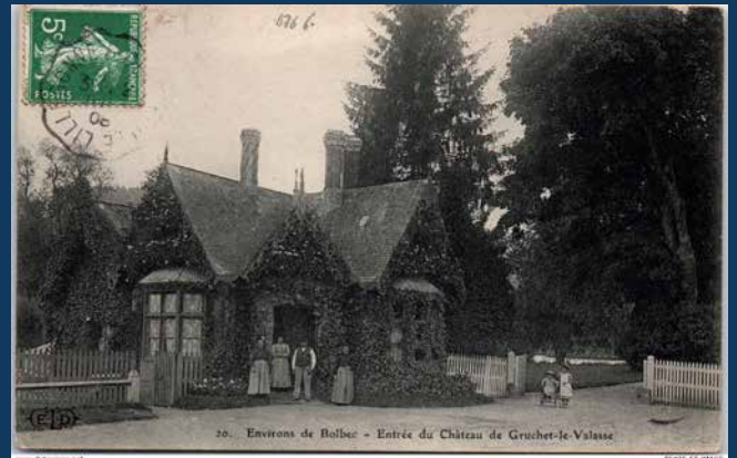
A l'extrémité sud du parc, près de l'étang, une nouvelle entrée est ouverte par les Fauquet Lemaitre, le long de la route de Bolbec à Lillebonne, gardée par une loge de concierges.
